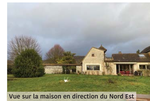
Vue sur la maison en direction du Nord Est
